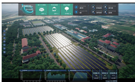
图 3 无锡市 X 水厂光伏发电项目
